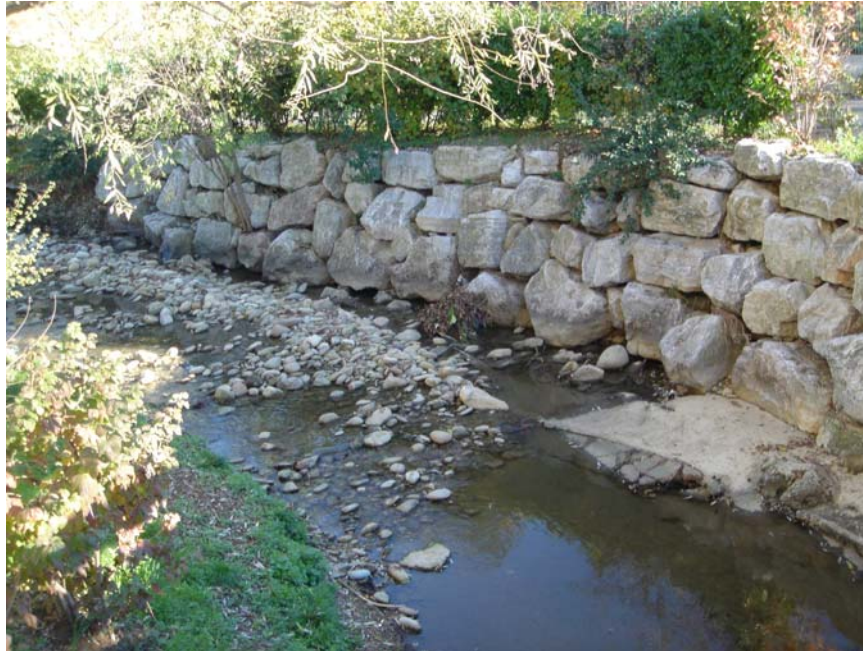
Fig. 31 – Scogliera in massi lungo il Torrente Quisa a sud di Via Cavalcanti
