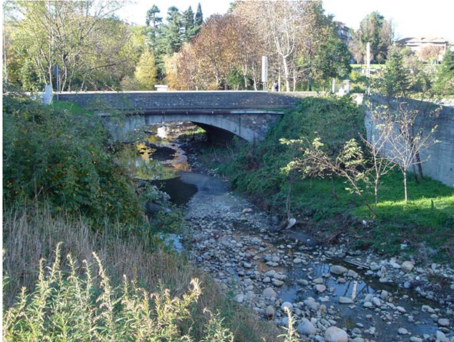
Fig. 23 – Tratto di Torrente Quisa su Via Lecco
