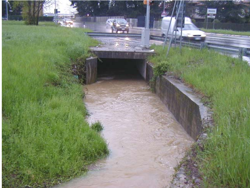
Fig. 33 – Torrente Riolo attraversamento sotto Villa d'Almè-Dalmine
